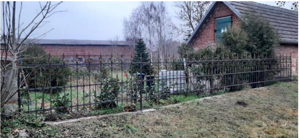
Neuer Zaun nach der Montage
