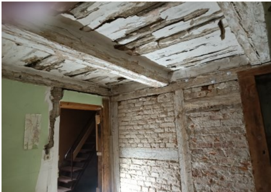
Blick auf Decke und barocke Trennwand im Untergeschoss
