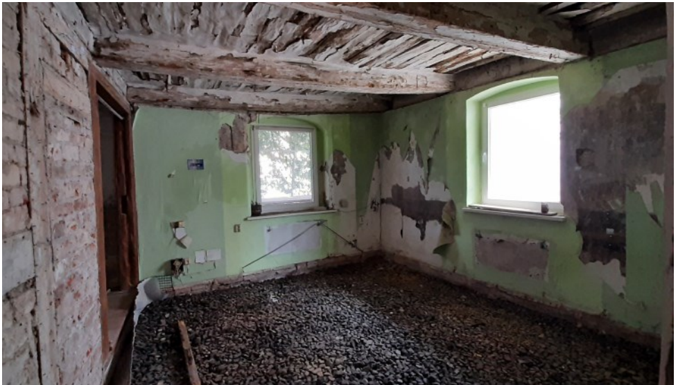
Von mächtigen Balken getragen: die mittelalterliche Geschossdecke im Elendshaus
